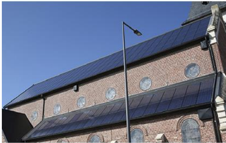
Figure 7 : Toiture de la chapelle de Loos-en-Gohelle (62)
